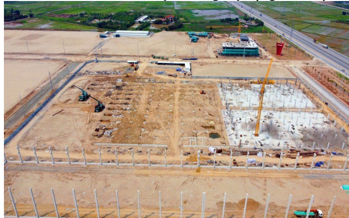
Hình 2: Hiện trạng Cụm CN Đặng Lễ (nằm trong CCN Hưng Yên) – đã hoàn thành san lấp và đang xây dựng nhà máy
