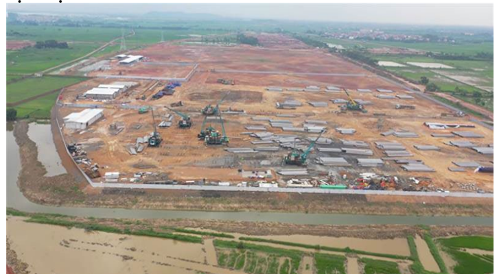
Hình 4: KCN Quế Võ 2 mở rộng, với việc xây dựng hạ tầng cho cụm dự án của Luxshare
