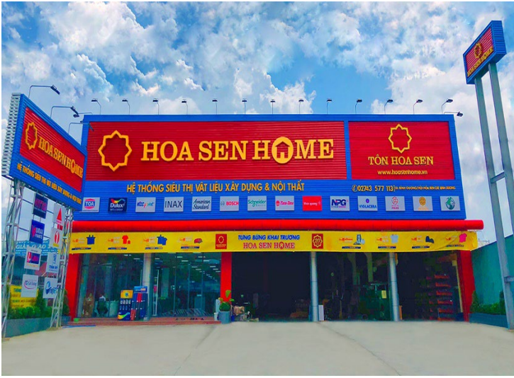
Hình 43: Hệ thống siêu thị vật liệu xây dựng Hoa Sen Home
